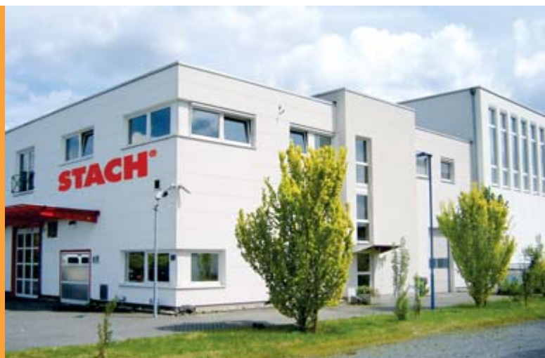
Das Firmengebäude der Druckerei Stach in Arnsberg-Neheim.
